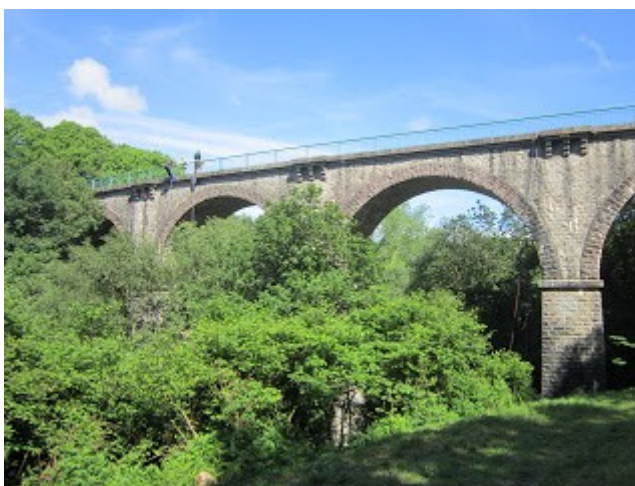
Le pont de Trémélé.
